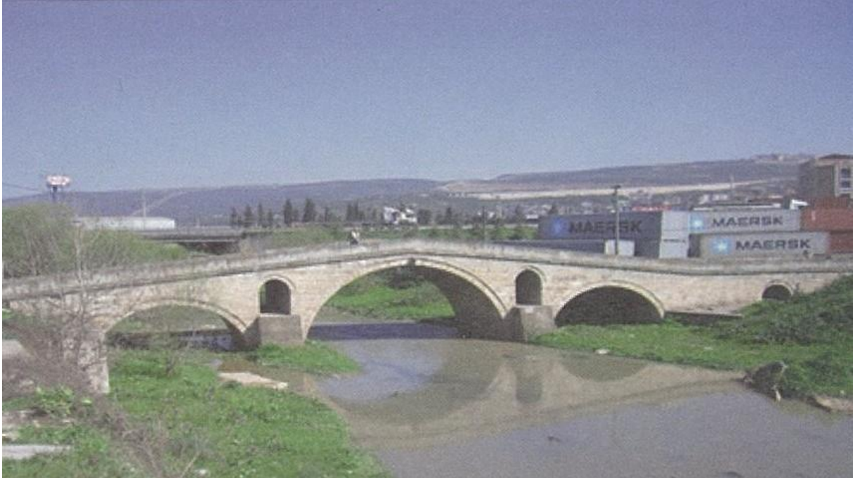
Dil Ovası Kanuni Köprüsü
