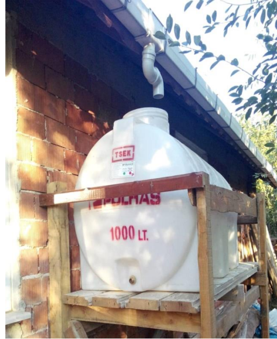
Şekil 2. Yağmur suyunun çatı oluklarından su deposuna alınması
